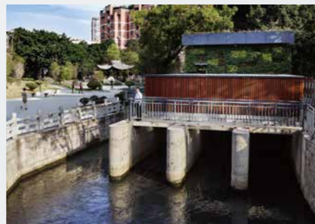
▲ 投入运行的一体化泵闸系统，与周边公园景观融为一体
